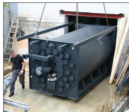
Einbau der Hackschnitzelheizung für Sonnbergschule und Mehrzweckhalle im Jahr 2010: 220.000 Kilogramm CO<sub>2</sub> werden dadurch jährlich eingespart.
