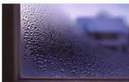
Veraltete Abstandhalter aus Aluminium sind stark wärmeleitend und führen oft zu Kondenswasser in Rahmennähe. Zeitgemäße Abstandhalter, oft als »warme Kante« bezeichnet, werden aus geeigneteren Materialien gefertigt und verbessern den U-Wert des Fensters um ca. 10%.
