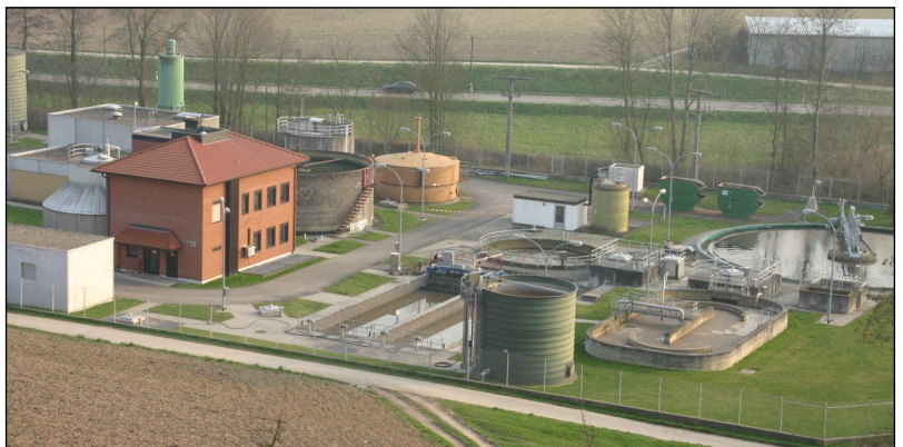
Auf dem Klärwerk am Eichersheimer Ortsrand soll eine Solaranlage installiert werden. Die zahlreichen Pumpen können damit versorgt werden. Foto: März
